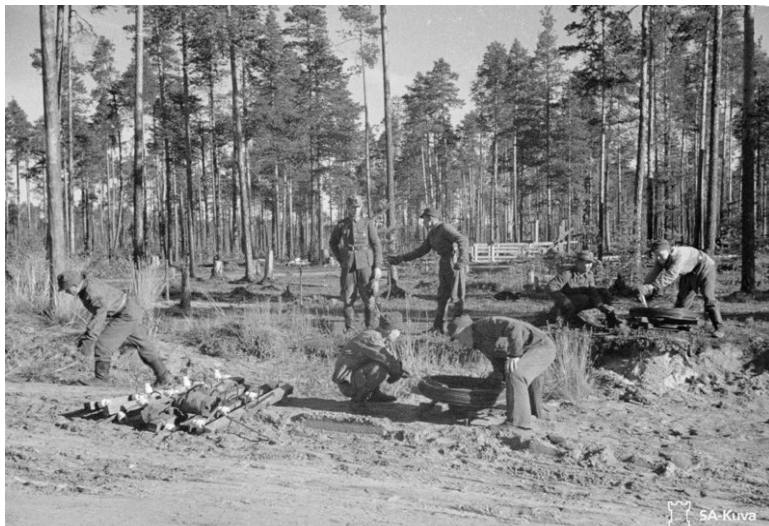
Kuvassa linjanrakennusryhmä lankariileineen Rukajärven suunnalla
